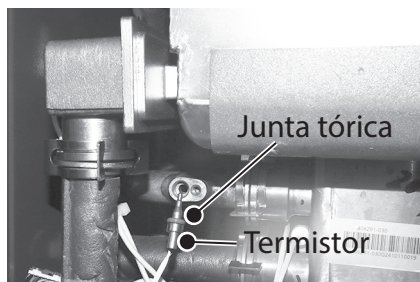
Figura 77 - Ubicación de la junta tórica del termistor
