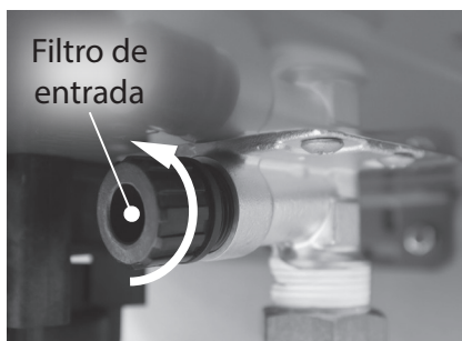
Figura 184 - Retiro del filtro de entrada
