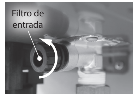
Figura 194 - Retiro del filtro de entrada
