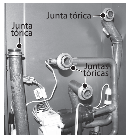
Figura 163 - Reemplazo de las juntas tóricas del HEX
